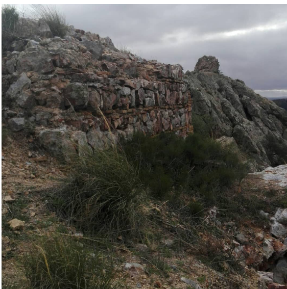
Figura 2. Aparejo toledano en el extremo norte del cerro de Malvecino. Fotografía: Asier Sánchez Jiménez.
