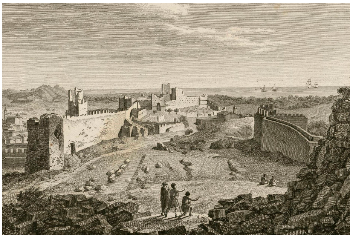
Figura 4. Grabado del castillo de Morvedre de principios del siglo XIX. Fuente: Laborde, 1811, t. I, p. 2: planche 104. A la derecha de la imagen se aprecia la iglesia de Santa María Magdalena con techo a dos aguas y una pequeña espadaña orientada al sur. Seguramente este edificio no sería el medieval, de cuya existencia en ruinas da noticia el mismo Laborde (1811, t. I, p. 2: planche 105).
