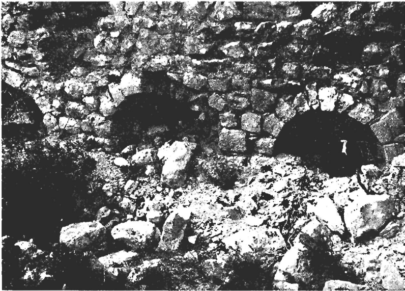
FIG. 17. Château d'Aguilar. Ébrasement intérieur des archères de la figure précédente.
